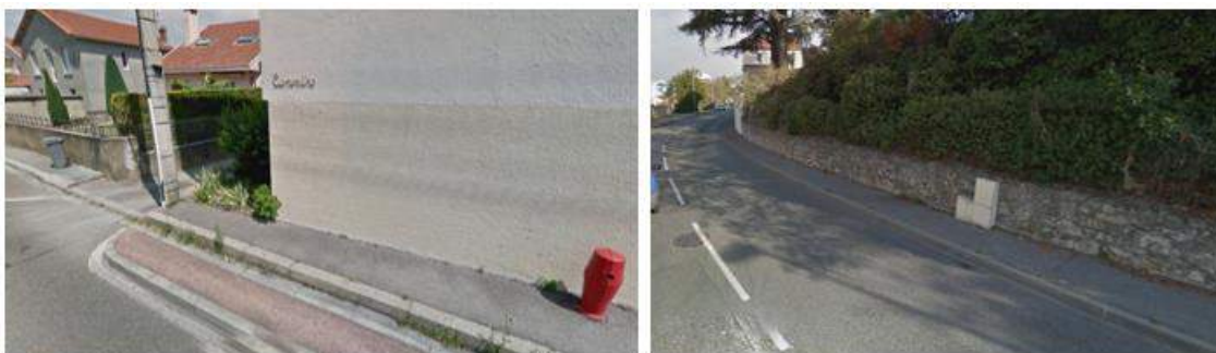
Figure 12 : Trottoirs pouvant constituer un frein à la marche à la rue Jean Clément / Rue Faventines (crédit photo : Onaps, ORS Auvergne-Rhône-Alpes – projet Parcoura)
